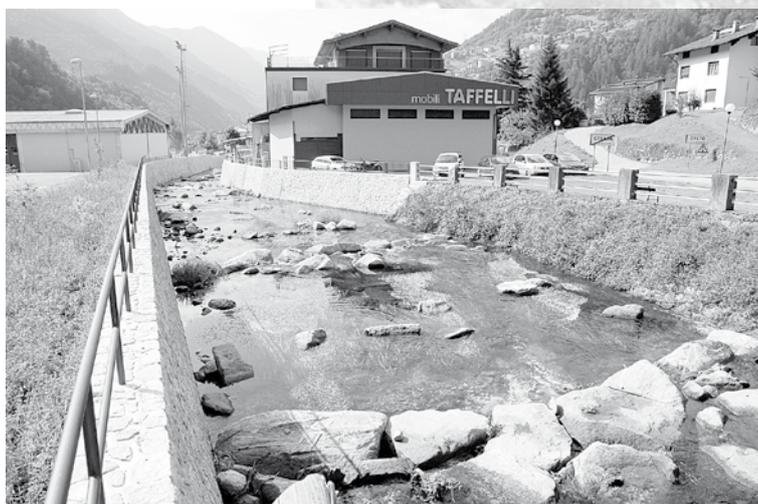
**Muri d'argine realizzati sull'Adanà tra Creto e Strada: l'artificiosità delle sponde, resa necessaria dalla ristrettezza degli spazi e dalla necessità di difendere gli edifici, è in parte compensata dal posizionamento di grandi massi che rendono meno monotono il fondo del torrente, favorendo in particolare la fauna ittica (2011)**
