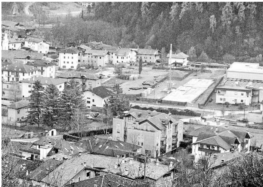
PRG - Area ex-Vela con i lavori per il nuovo Polo Protezione Civile
