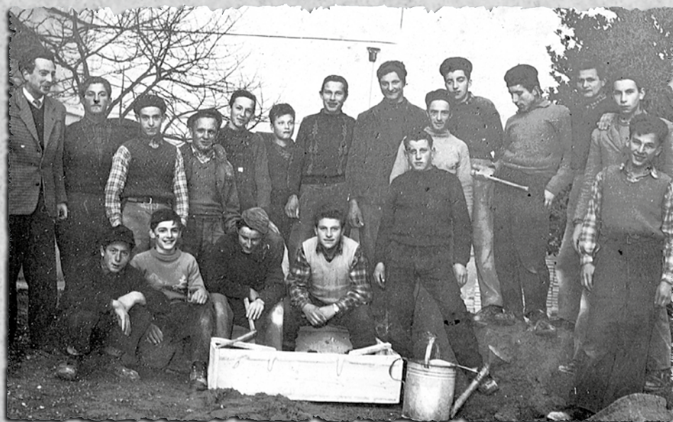
Cortesia di: Costanza Armani Soggetto: Corso di muratore a Creto Persone: operai provenienti dai paesi della Pieve di Bono Località: Creto Anno: 1955
