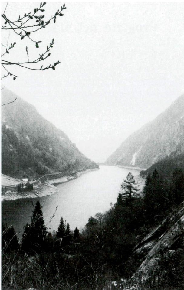
VAL DI DAONE - BACINO IDROELETTRICO DI «BOAZZO» (Fotoamatori P. Bono, 1988).
