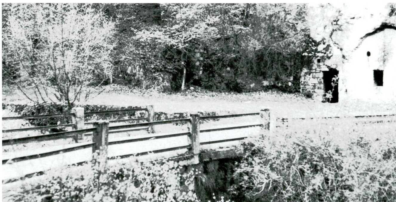
SENTIERO DELLA PACE - AREA DI SOSTA AL RIO MARACH (in via di realizzazione).
