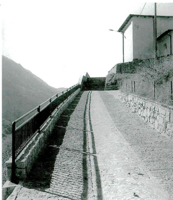
Por - Pavimentazione Salita alla chiesa (foto Ruggero Rota).
