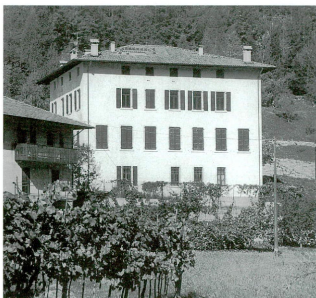
Agrone - Ristrutturazione Casa frazionale (foto Ruggero Rota).
