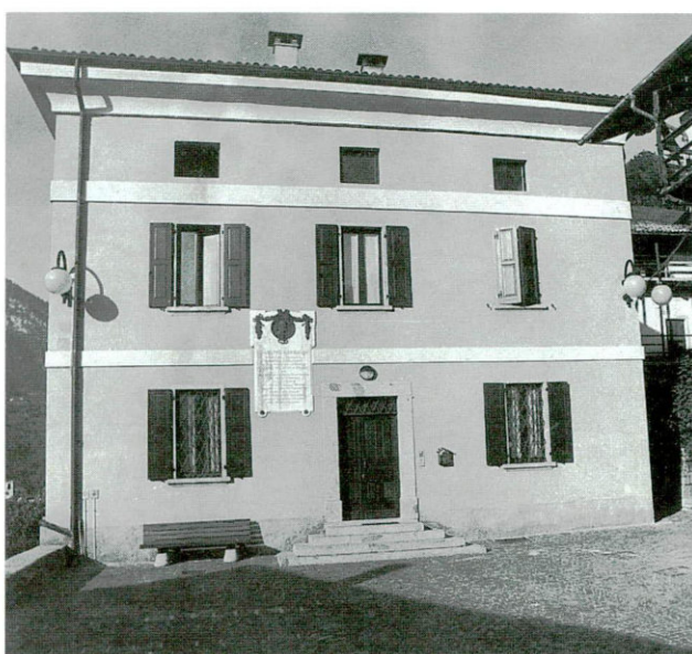
Cologna - Intervento di ristrutturazione Casa frazionale (foto Ruggero Rota).
