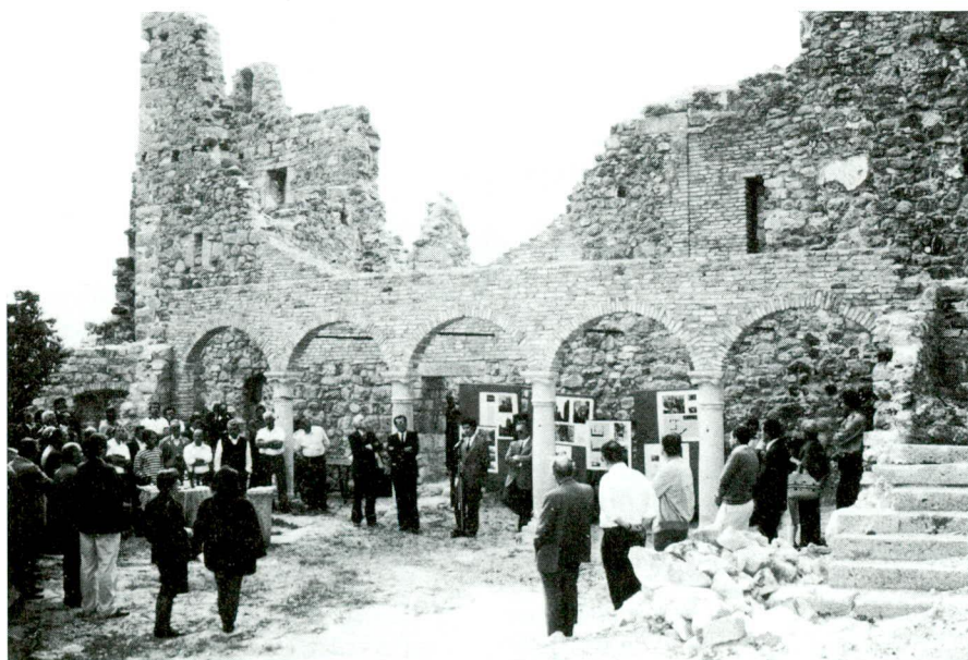
NEL CORTILE RINASCIMENTALE PARLA L'ARCHITETTO CODROICO: L'ESPERTO FUNZIONARIO DELL'ASSESSORATO PROVINCIALE CHE DIRIGE I LAVORI DI RECUPERO DEL CASTELLO.
