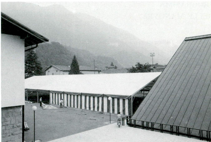
Il «capannone delle feste» allestito al Centro Scolastico per la «Sagra del Folclore».
