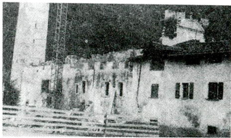
Si sta ristrutturando l'edificio destinato ad ospitare l'oratorio di Pieve di Bono.
