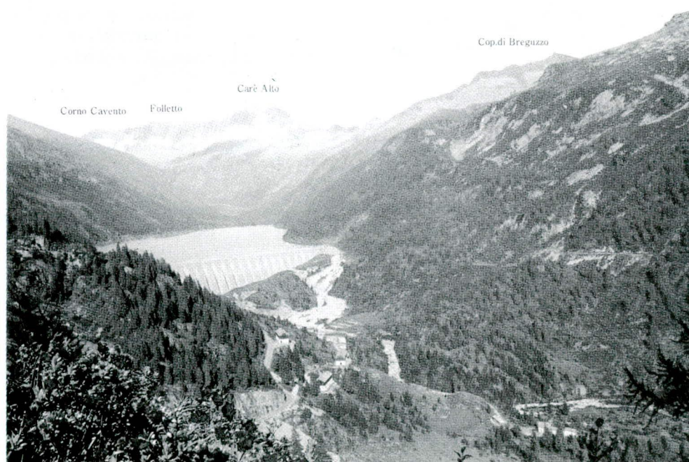
VALLI DI DAONE E DI FUMO - DIGA DEL BACINO DI MALGA BISSINA (m. 1800) - (Foto Cart. G. Pedrotti e C., Trento).
