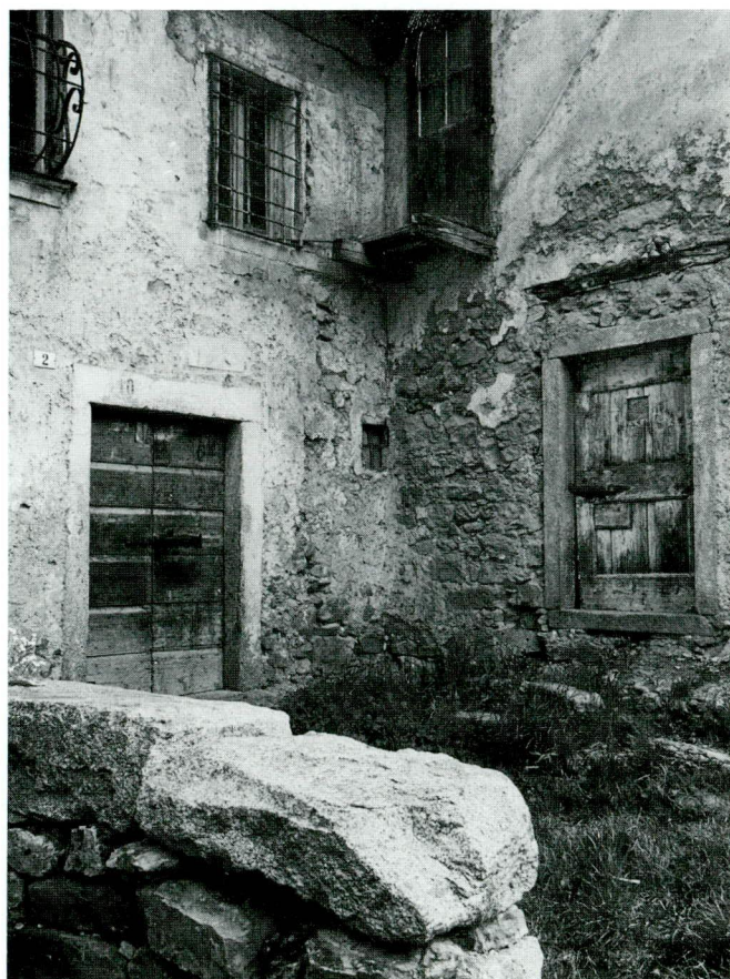
STRADA - SCORCIO CON PORTALI, CATENACCI, INFERRATE.
