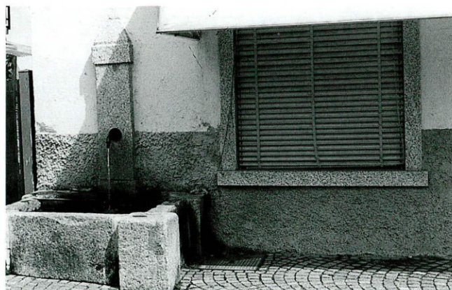
Strada: il "vecchio" granito tagliato a mano e quello "nuovo" segato a macchina.
