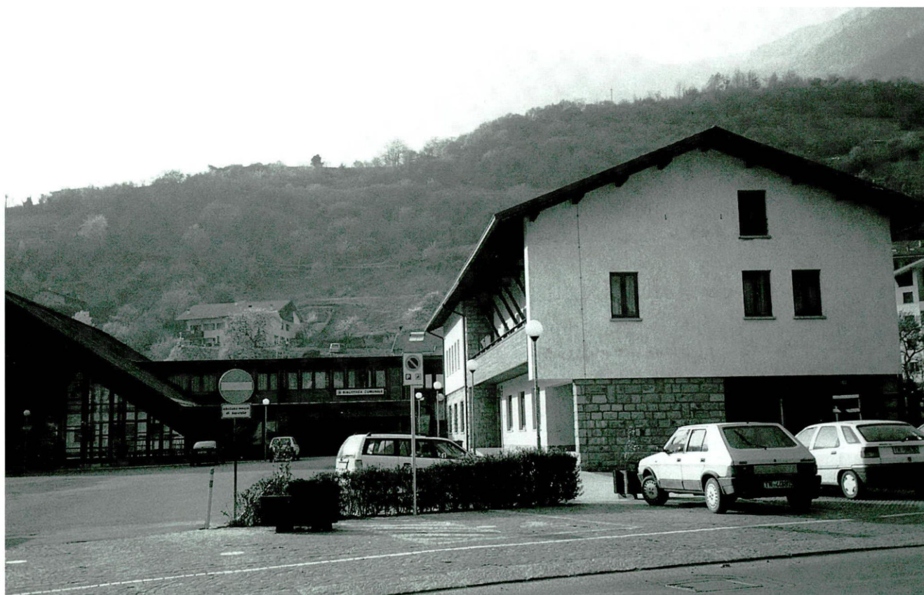
Panoramica del centro scolastico di Pieve di Bono.
