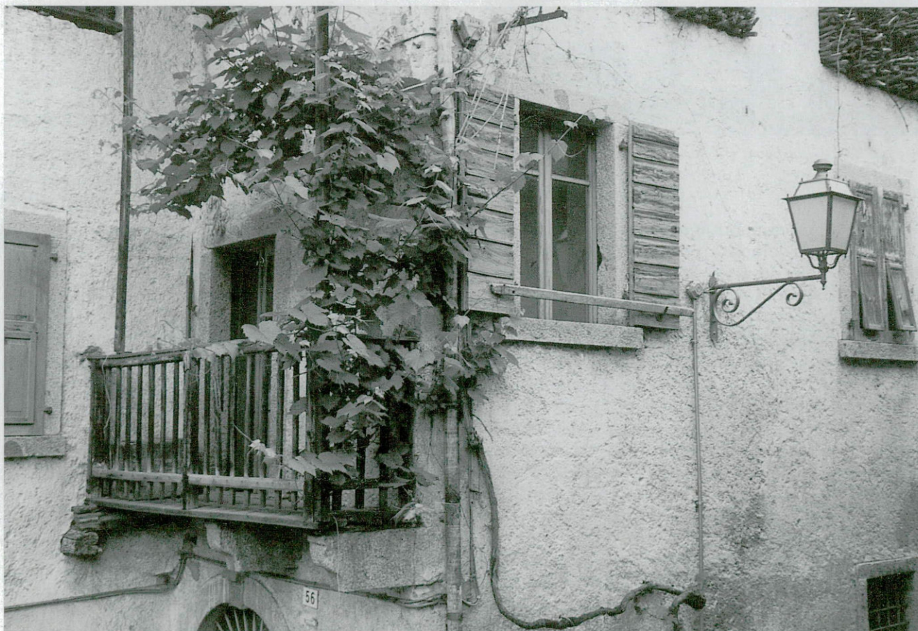
Un caratteristico angolo di Creto in via Levido.
