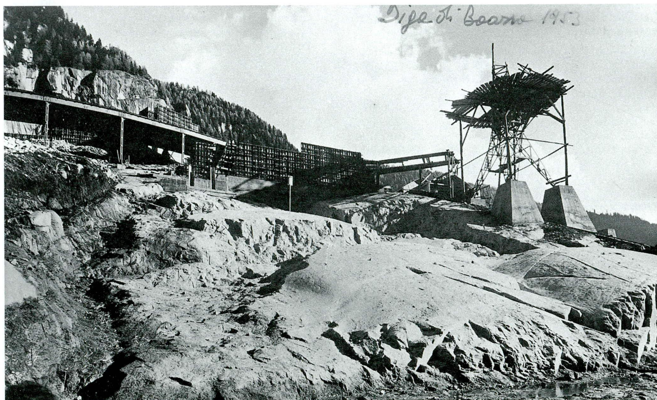
Val di Daone - Lavori alla diga di Boazzo 1953 (Cortesia: Livio Losa).
