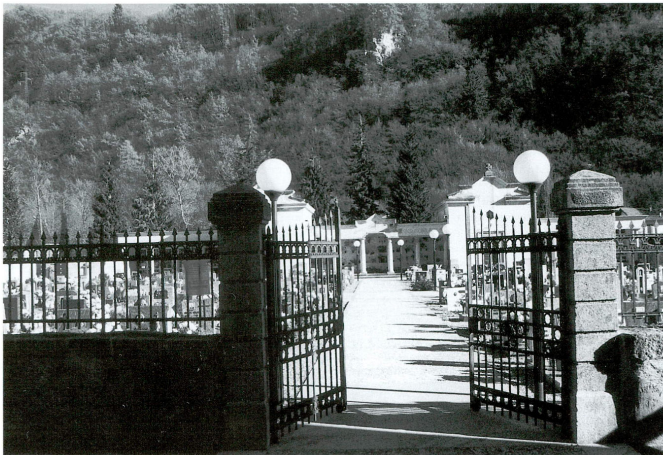
Il cimitero di Creto dopo la ristrutturazione
