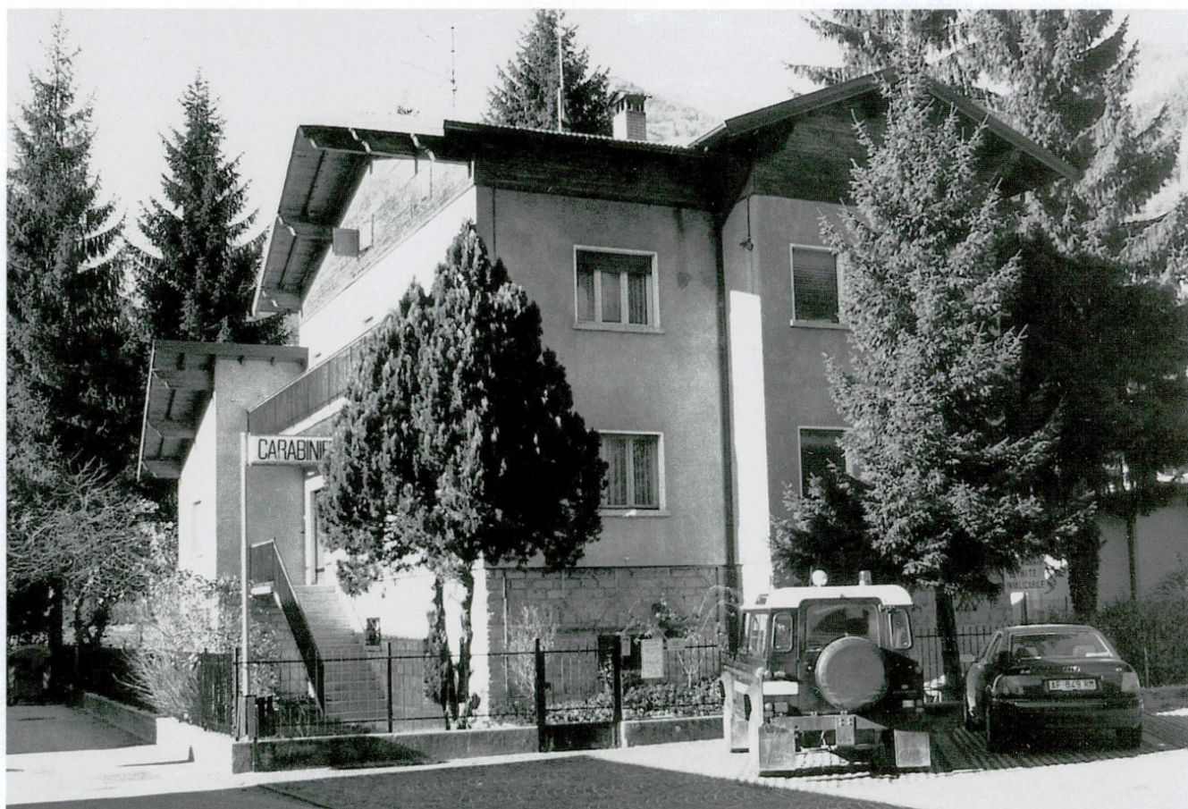
La Caserma dei Carabinieri, uno dei prossimi interventi di ristrutturazione.
