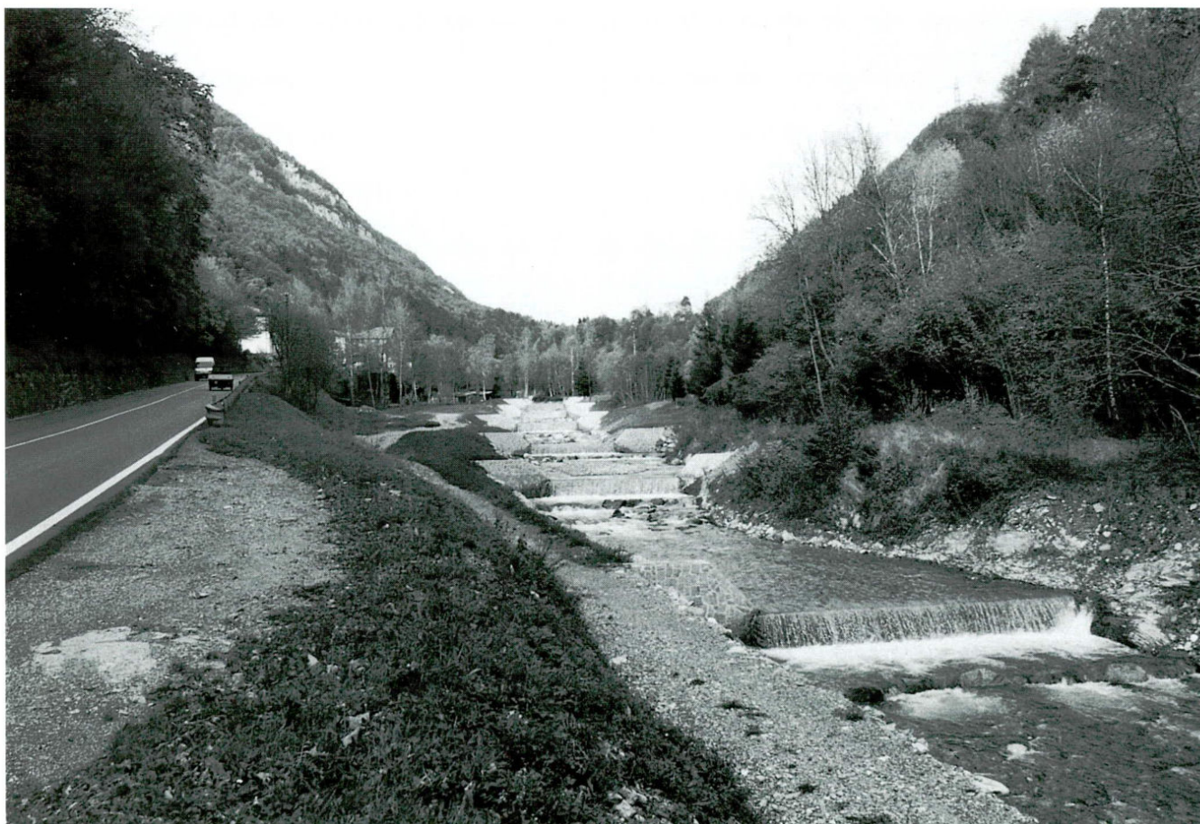
I lavori di sistemazione del torrente Adanà.
