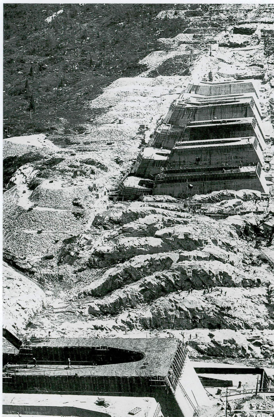
Anno 1956 - La diga di Bissina vista dall'imposta di destra
