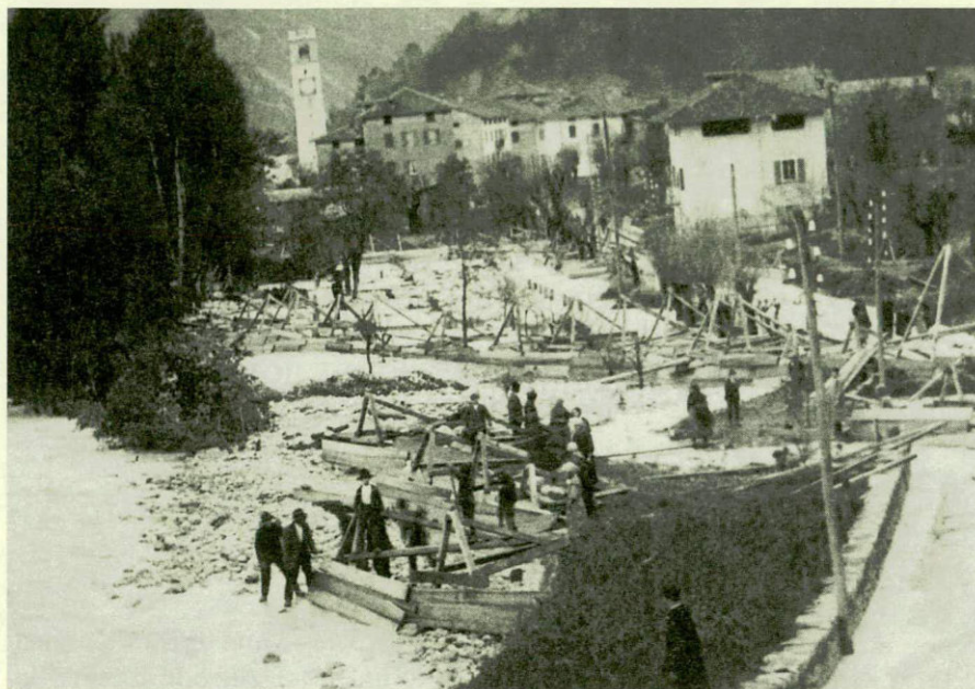
Alluvione del 1928 Ponte di Prezzo
