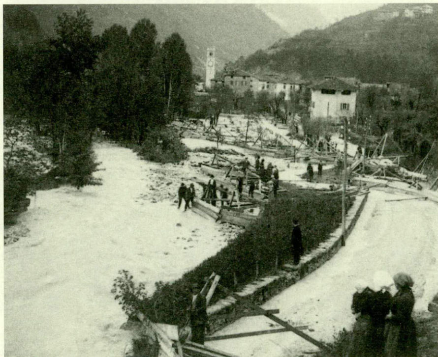
Alluvione del 1928, Ponte di Prezzo
