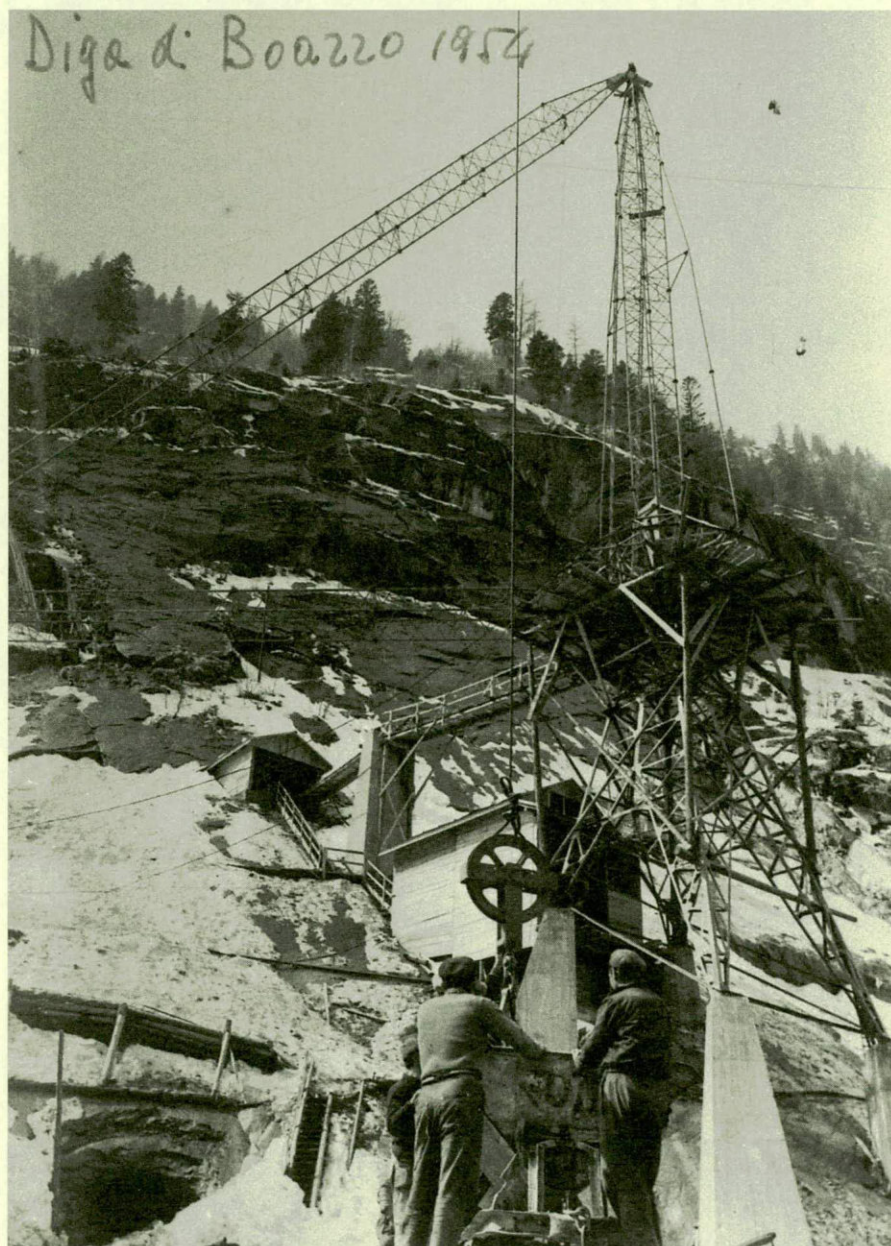
Lavori alla diga di Boazzo
