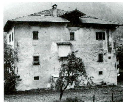
FOTO 4 «EL PALAZZ»: visto da Nord.
