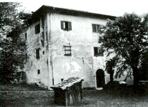
FOTO 2 «EL PALAZZ»: facciata Est.
