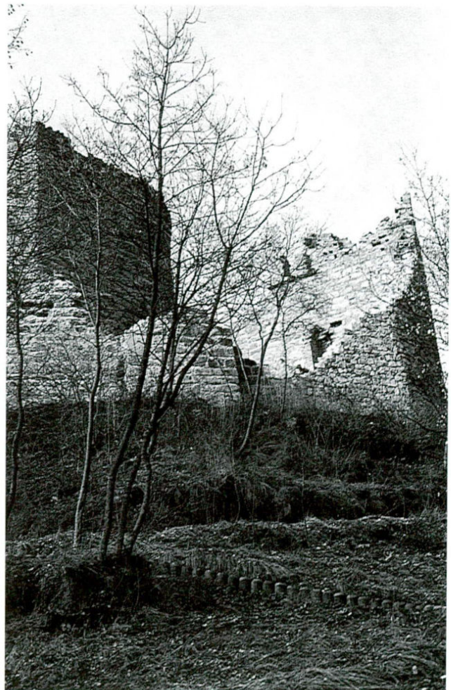
Castel Romano - muri perimetrali.
