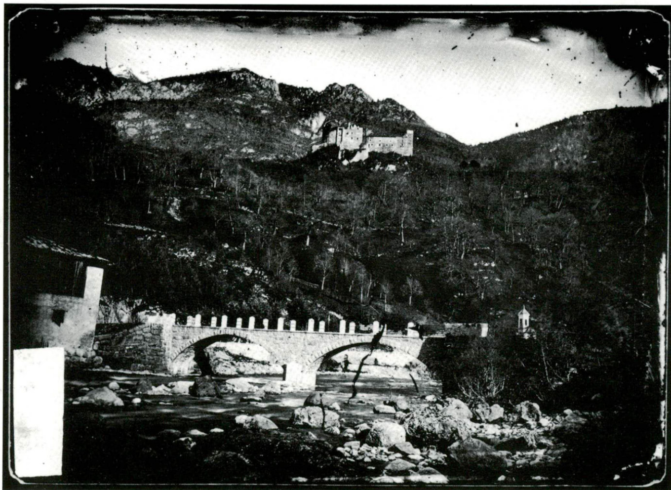
«IL PONTE DI PREZZO COL CASTEL ROMANO» (PROPRIETÀ P.A.T.). DA: G.B. UNTERVEGHER, LASTRE AL COLLODIO 1862-1880. ED. P.A.T., TRENTO 1982.
