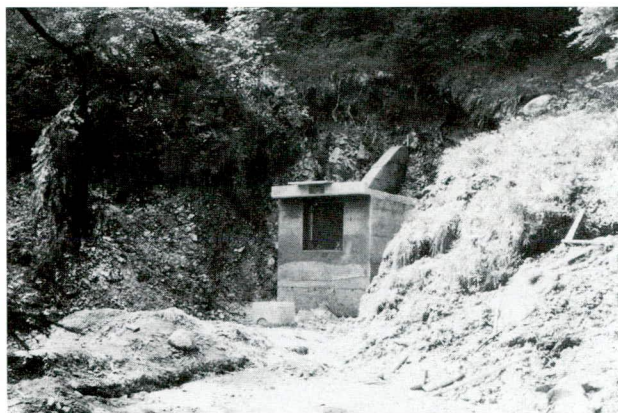
OPERA DI PRESA DELLA SORGENTE «ACQUA ROSA» IN LOCALITÀ «CEI».
