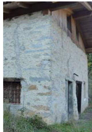
Fig. 7b: Particolare finitura raso sasso
