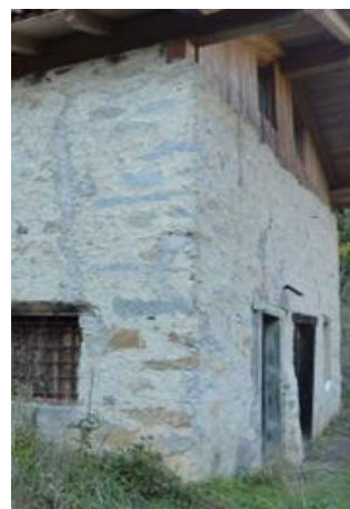
Particolare intonaco "raso sasso"
