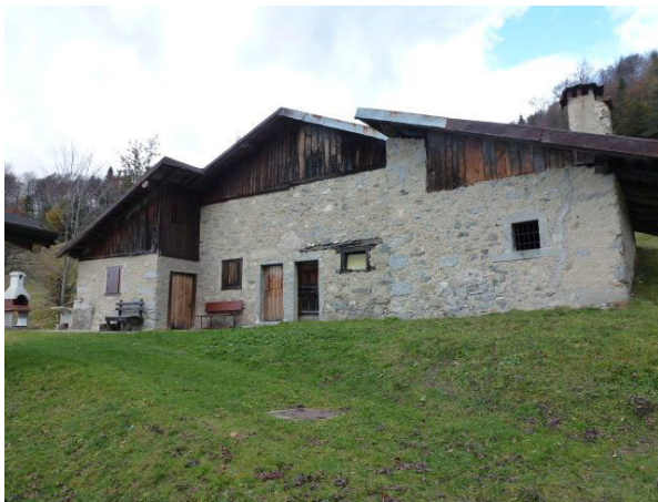
Fig. 7a: Finitura esterna in malta calce spenta
