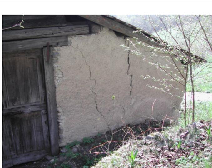
Foto 4: particolare ovest con fessurazioni
