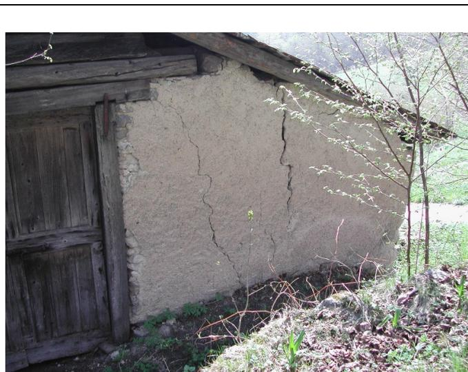
Foto 4: particolare ovest con fessurazioni
