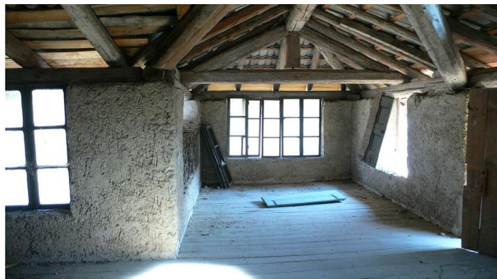
Esempio di struttura interna di un tetto a padiglione
