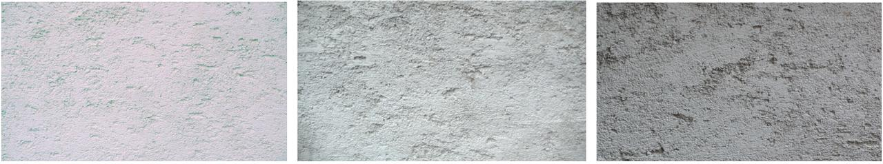
Intonaco con inerte grossolano e lisciatura con fratazzo in legno
