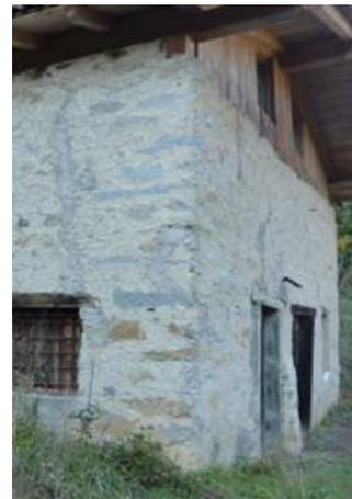
Fig. 7b: Particolare finitura raso sasso
